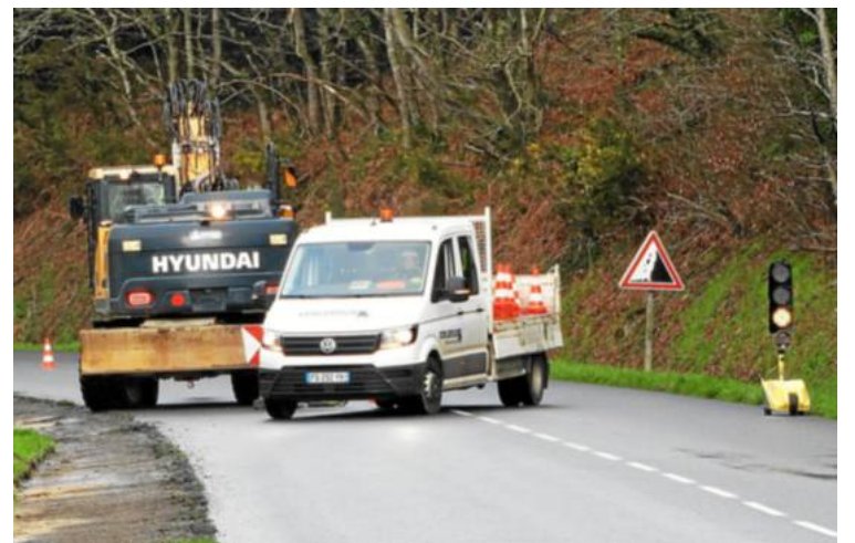
es feux tricolores régulent la circulation pour ces travaux, avant fermeture complète pour deux nuits, du 12 au 14 avril.
