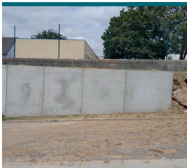
Terrassement pour la réalisation d'un mur béton au niveau de l'école Saint Adrien au Drennec
