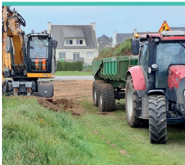
Suppression de talus et préparation pour la pose de grillage au château d'eau de Plouvien
