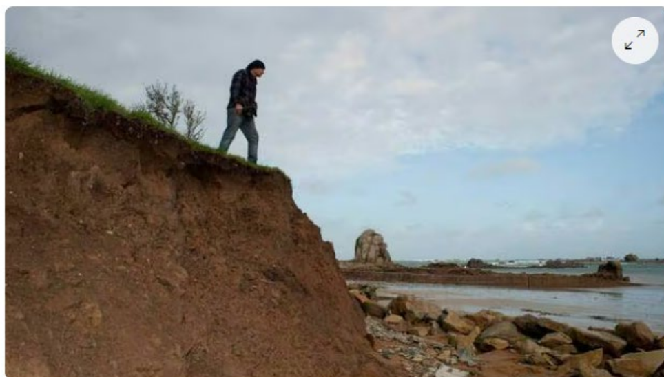
La forte houle, les coefficients de marées élevés, cumulés aux pluies, sont des facteurs accélérateurs de l'érosion des falaises, ici dans les Côtes-d'Armor, à Plougrescant. | ARCHIVES OUEST-FRANCE
