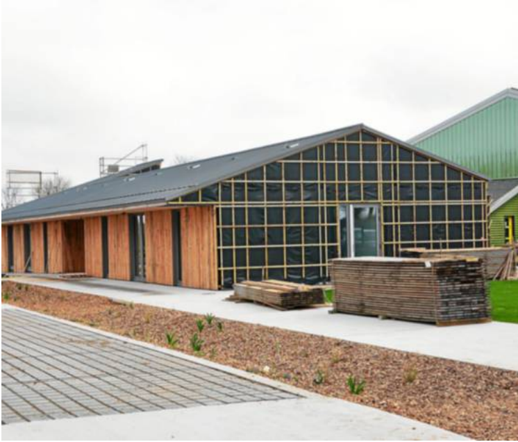
Les travaux vont bon train au centre technique communautaire de Bourg-Blanc, le plus gros investissement pour 2025.
