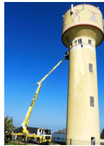
Les techniciens ont dû travailler à une belle hauteur pour installer les trois antennes 5G.
