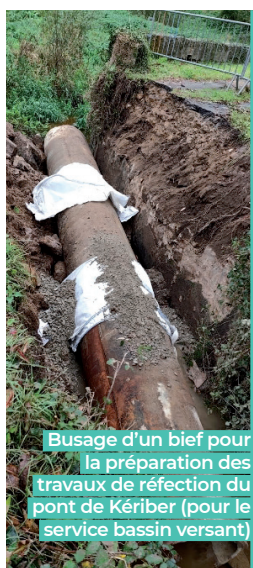
Réfection d'un chemin d'exploitation à Plouvien (pour le service bassin versant) • Pendant / Après
