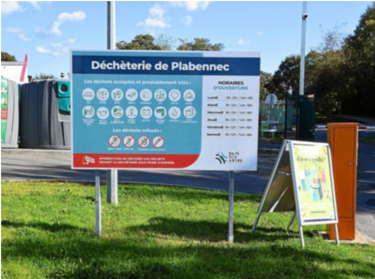
La candidature à l’appel à projets pour la partie études doit engager le processus qui engageront les travaux de rénovation et de mise aux normes pour la déchèterie de Plabennec.
