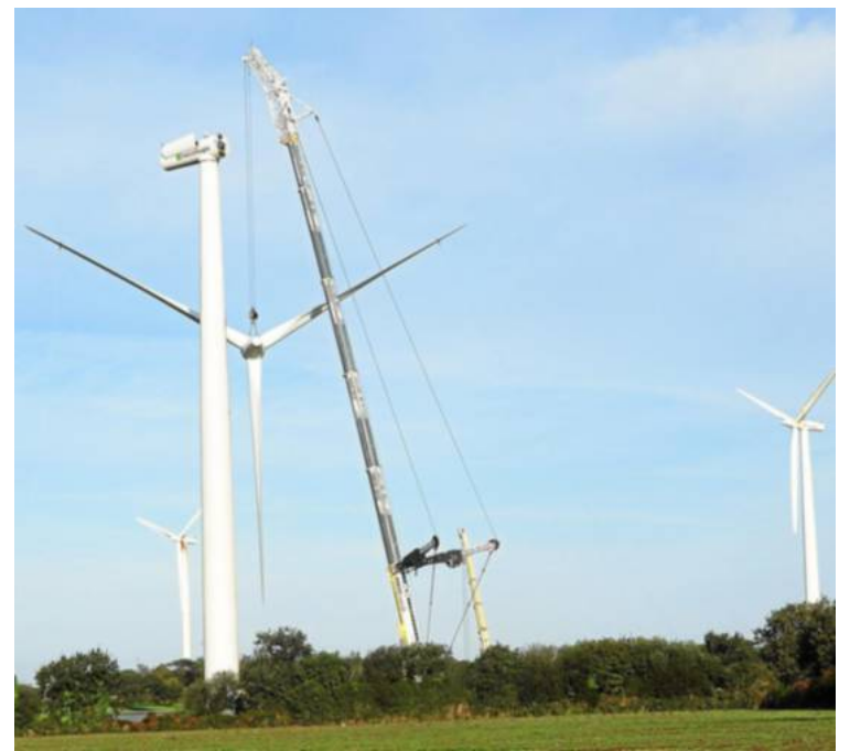
Le chantier a débuté par la descente des pales de l'éolienne T3.
