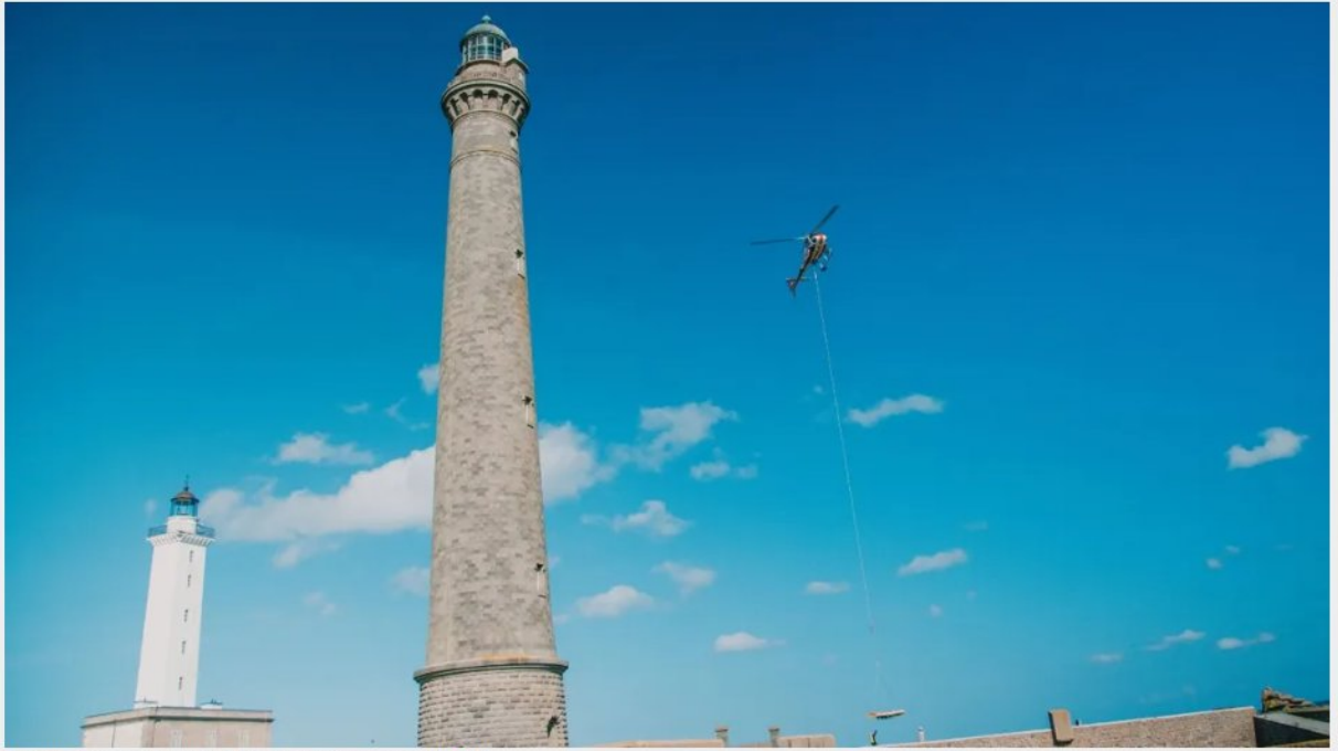
Le chantier va durer 14 mois, jusqu'en 2027.
