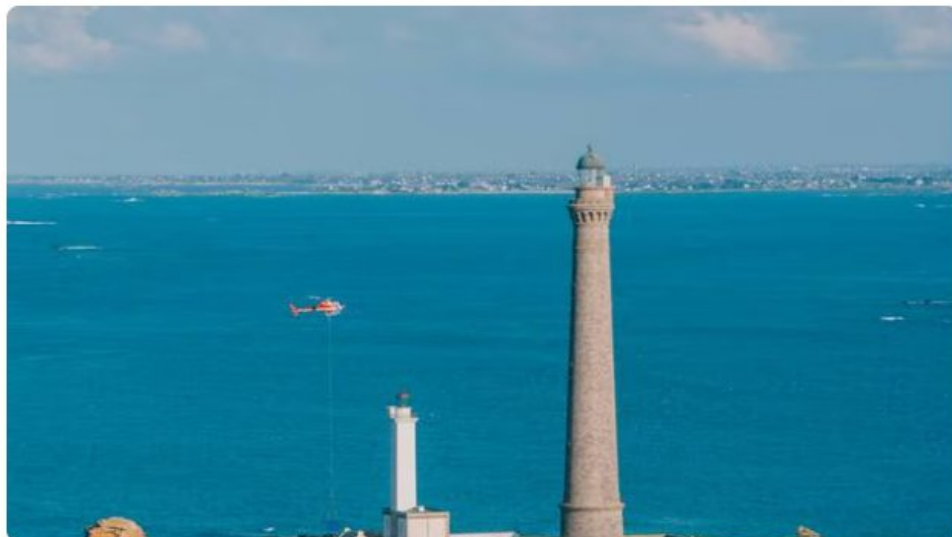
L'hélicoptère a transporté 60 tonnes de matériaux jusqu'au phare de l'île Vierge. | OUEST-FRANCE
