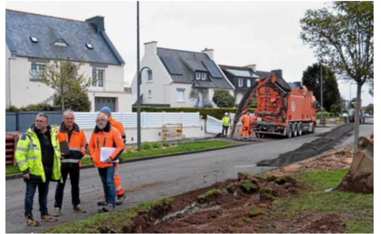
À gauche, Sébastien Cueff (à gauche), responsable des services techniques, et Yves Le Goff, adjoint au maire responsable des travaux, visitent le chantier réalisé par TPC Ouest (Guipavas) avec la maîtrise d'œuvre confiée par le Pays des Abers à Urbateam Saint-Renan.
