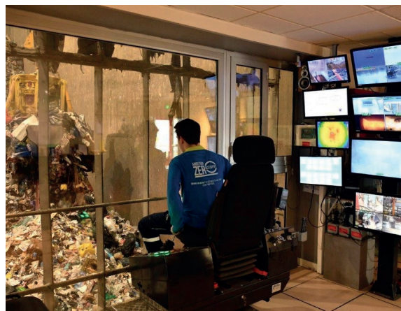
Salle des machines de l'UVED du Spérnot Photo de Sotraval 2021
